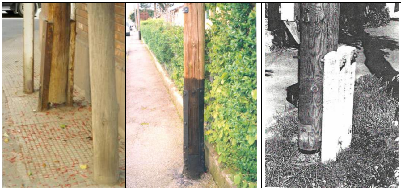
Fondations métalliques et en béton armé
